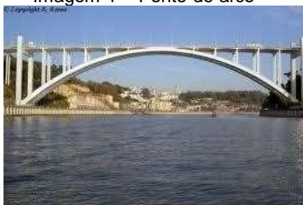
Imagem 1 – Ponte de arco
