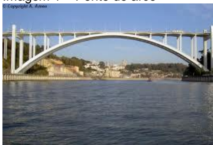
Imagem 1 – Ponte de arco
